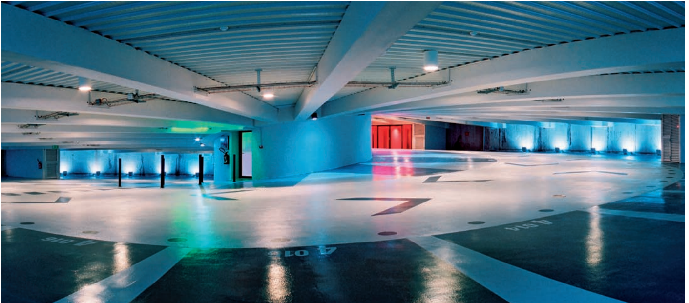
PARKING ARVIEUX. Marseille - France
