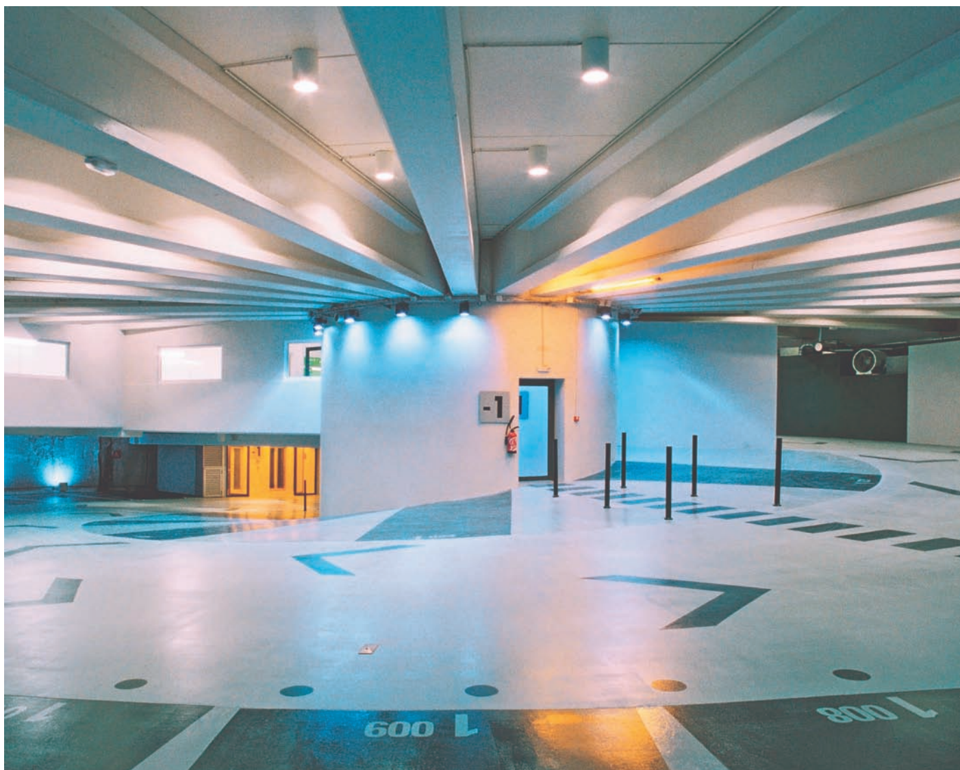
PARKING ARVIEUX. Marseille - France
