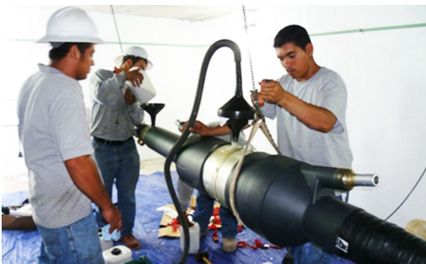
Montage av kabelskarvar med skärmseparation, JX 245.
