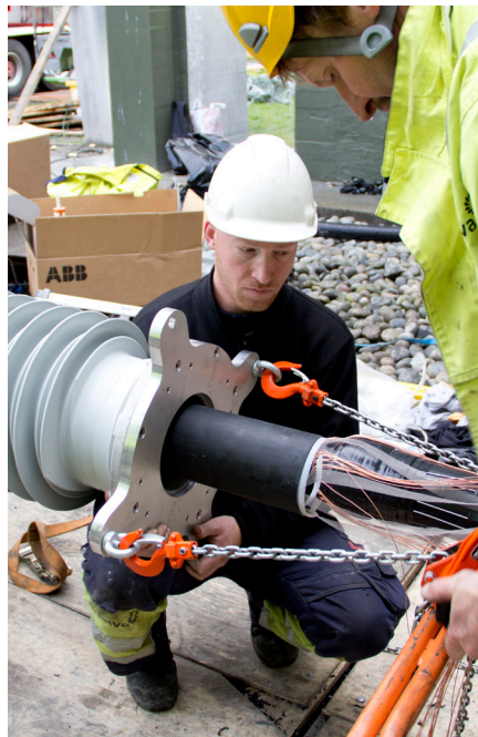
Installation av torra kabelavslutningar, TD 145 kV.
