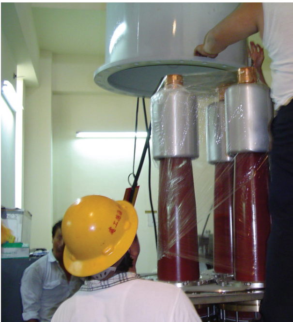
Kabelavslutningar APEGA monterade i GIS gasisolerad ställverk.
