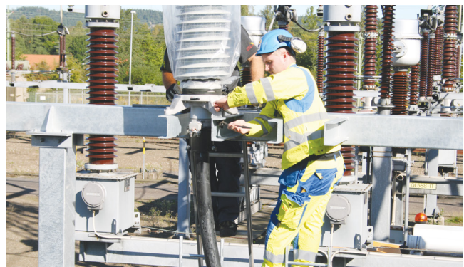
Installation av kabelavslutning, APECB.
